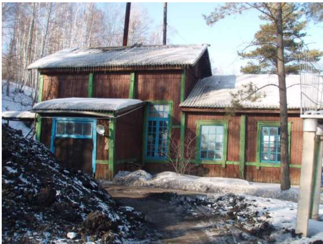
Насосная станция Гонжинского водозабора
