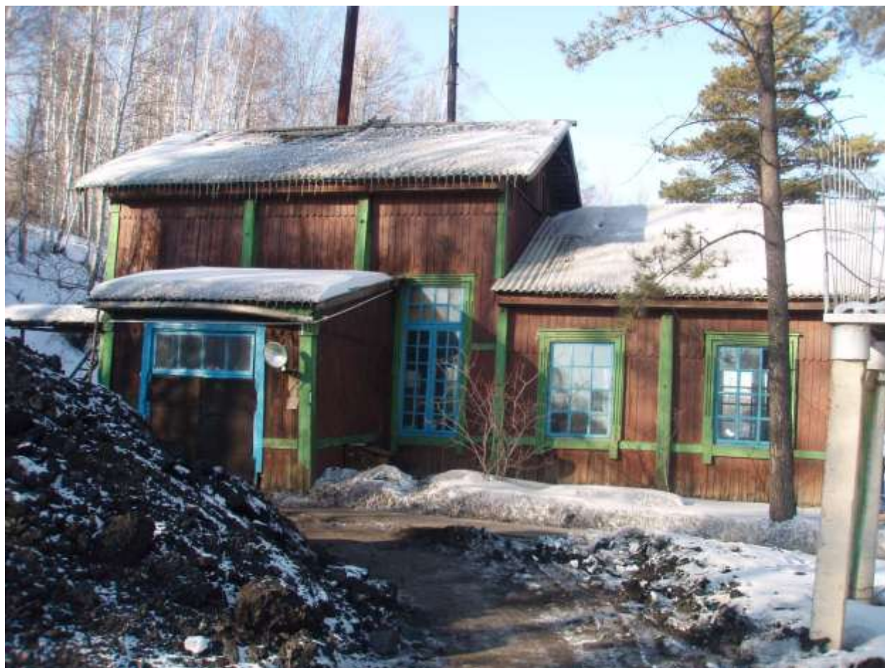
Фото 7.1.1. Здание насосной станции
