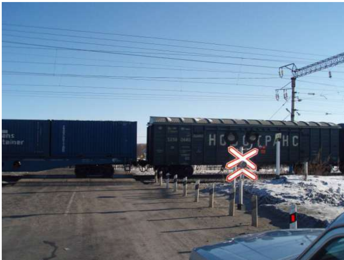
Фото 6.1.1. Ж/Д переезд в с. Гонжа
